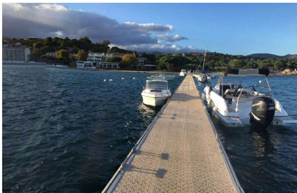
Figure 3 : Cale de mise à l'eau et ponton de débarquement de Pinarello 1 (en haut) et Pinarello 2 (en bas).
